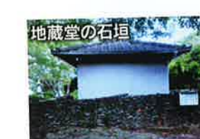
地藏堂の石垣 浜石を2.5kmにわたり、手繰りで運び上げた石垣(市指定)
