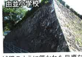
由並小学校 城壁のように築かれた見事な石垣、創立当初からクスの校木
